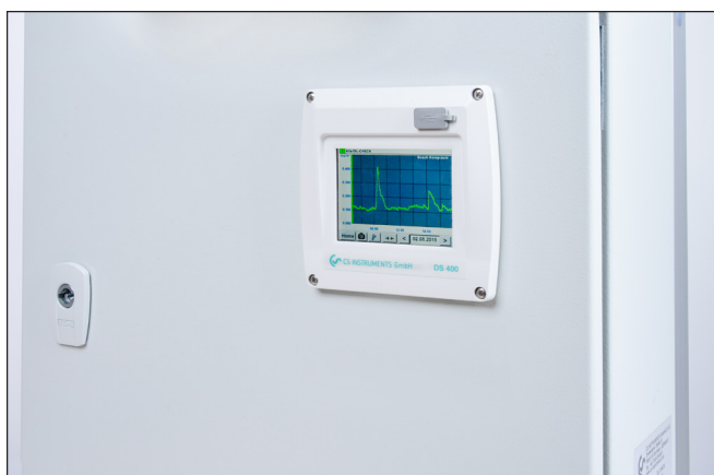
Montering i kopplingskåp
