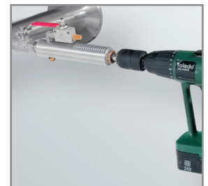
Anbohren unter Druck mit der CS Bohrvorrichtung
