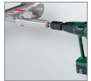
Perforación bajo presión con el dispositivo de perforación de CS
